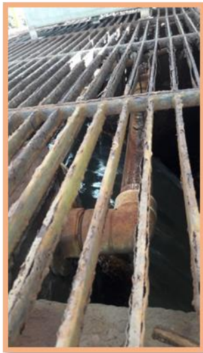
Desgaste das grades no local de preparo e dosagem de químicos para a Estação de Tratamento
