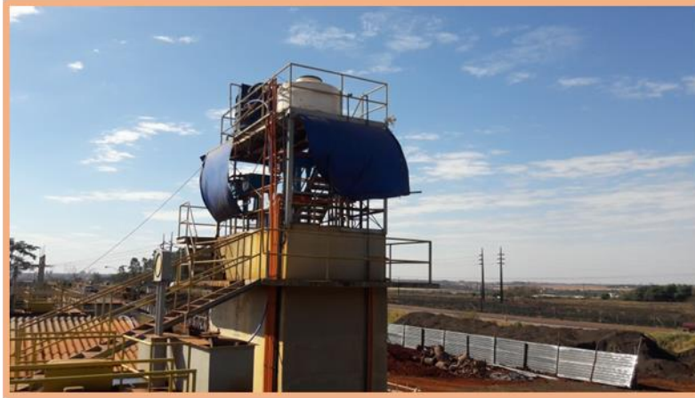
Preparo e Dosagem de químicos para a Estação de Tratamento
