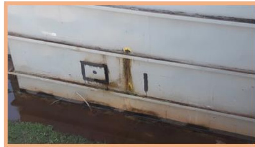
Vazamento na Estação de Tratamento (piso molhado)
