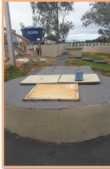
Vista externa ETEB-001
