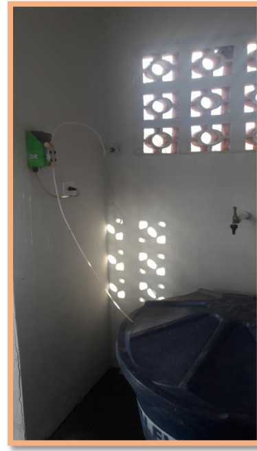
Sistema de Desinfecção – Hipoclorito de Cálcio
