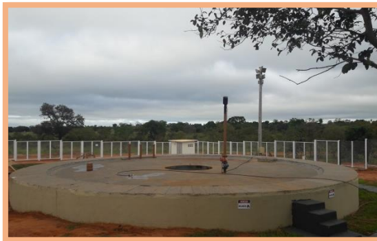
Vista do Reator UASB
