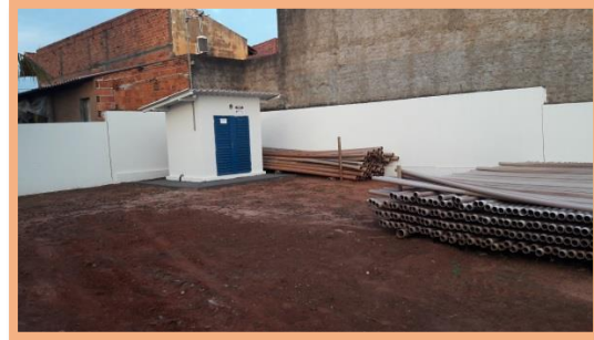
Armazenamento de tubos na área do BRA-004
