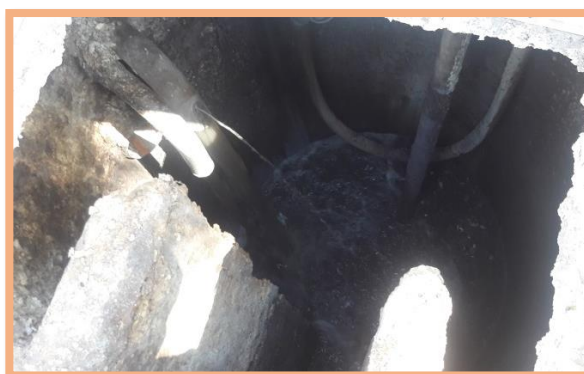
Poço da EEE-007
