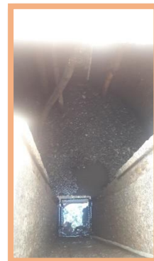
Poço da EEB-001
