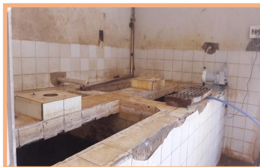
Tanque de preparo dos Produtos Químicos
