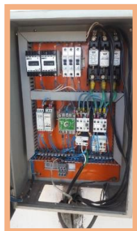
Quadro de Comando da EEE-006
