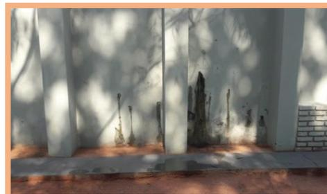
Infiltrações na parede do reator
