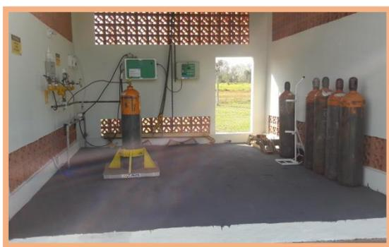
Área de armazenagem dos cilindros de Cloro Gasoso e sistemas de segurança
