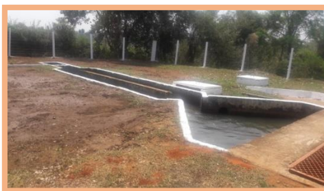
Desarenador Captação Jardim - Entrada
