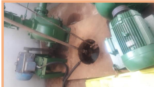
CJ motor+bomba Captação de Água Bruta Jardim
