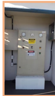
Abrigo do Quadro de Comando ITQ-003
