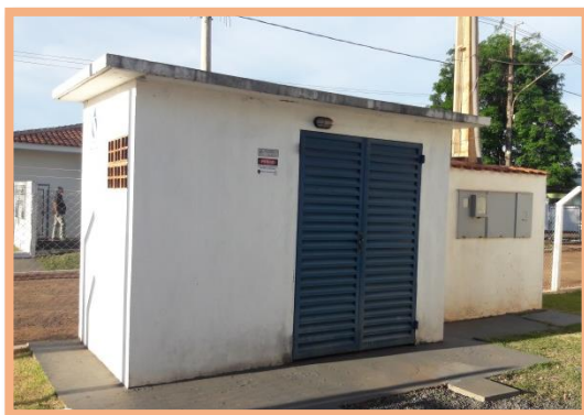
Abrigo do Quadro de Comando ITQ-004
