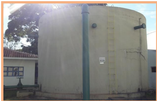
Reservatório Apoiado RAP-001
