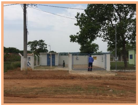
Vista da Área do FIG 006
