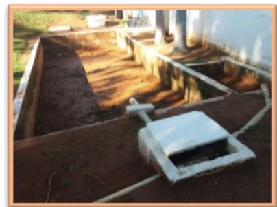
Caixas de lodo e de areia
