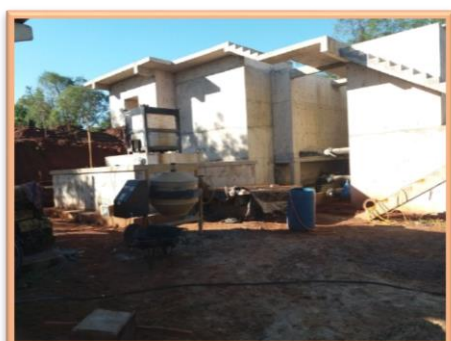
ETA convencional em construção
