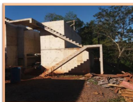
Nova ETA em construção
