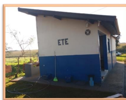
Abrigo do laboratório e serviços gerais
