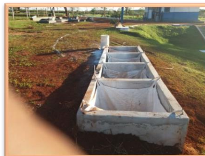
Caixas de areia
