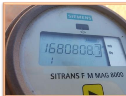
Macromedidor com tampa solta
