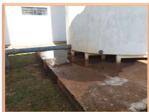
Pequeno vazamento na base do RAP-002
