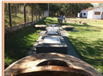
Entrada de esgoto bruto e pré-tratamento
