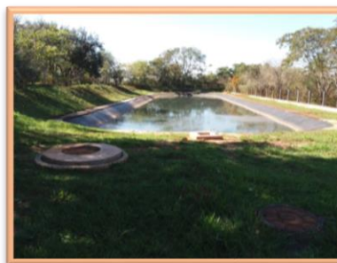
Lagoa de estabilização
