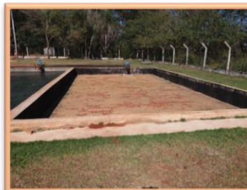
Novo leito de secagem do lodo
