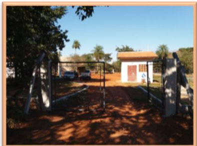
Vista da ETE-001
