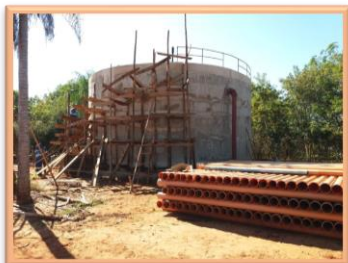
RALF em construção
