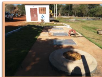
Novo gradil e desarenador
