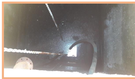
Poço de Sucção da EEEB-002
