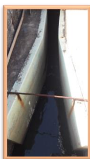
Medição de vazão com régua
