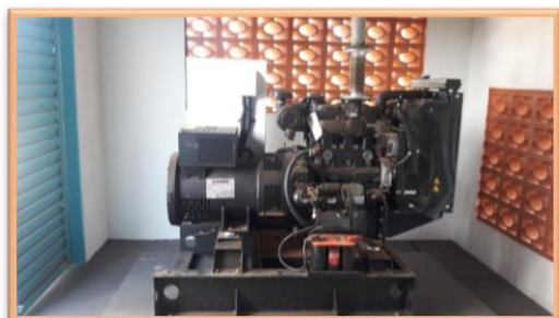
Gerador de emergência
