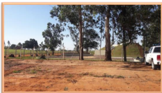
Vista da ETE-001
