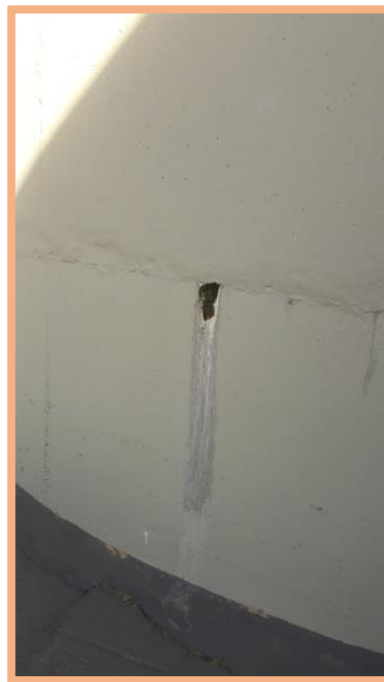
Ponto de vazamento
