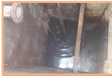
Poço de Sucção da EEEB-001
