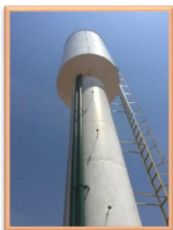
REL-001 sem para-raios
