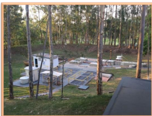
Vista geral da EEE-001
