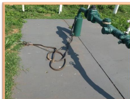
Cabos expostos às intempéries
