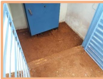
Marca de água pluvial na cabine do QCE
