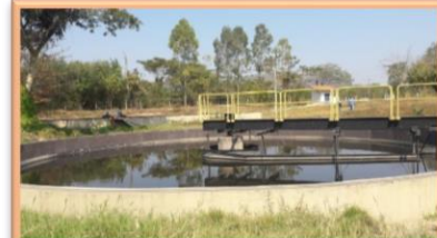
Segundo decantador secundário
