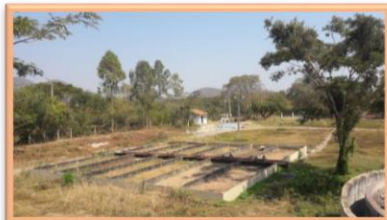
Leitos de secagem do lodo
