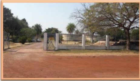
Vista da entrada da ETE-002
