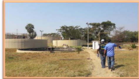
Vista geral da ETE-002
