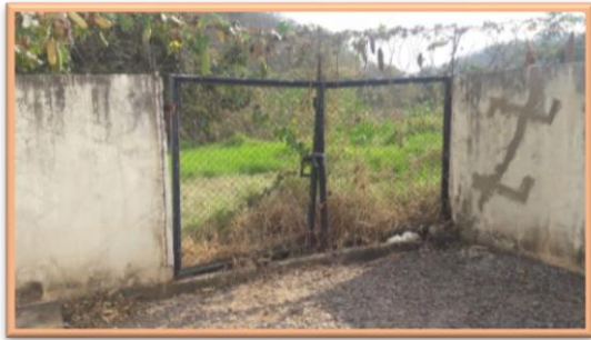
Portão dos fundos danificado
