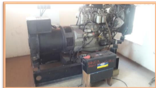
Gerador de emergência
