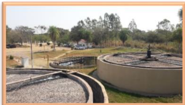
Filtros biológicos e Decantador secundário
