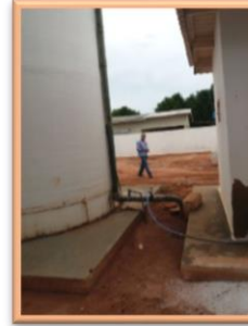
Injeção do tratamento no RAP-001
