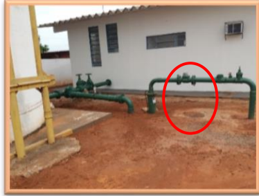
Vazamento no flange do tubo camisa (EAT-001)
