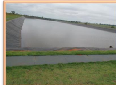
Lagoa de decantação
