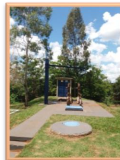
Bombeamento de esgoto tratado
