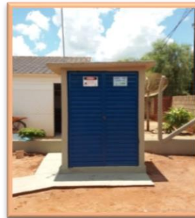
Abrigo do quadro elétrico
