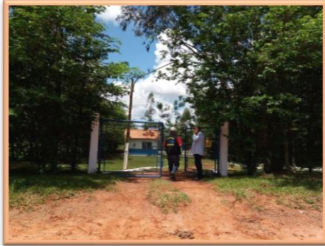
Vista da entrada da ETE-001
