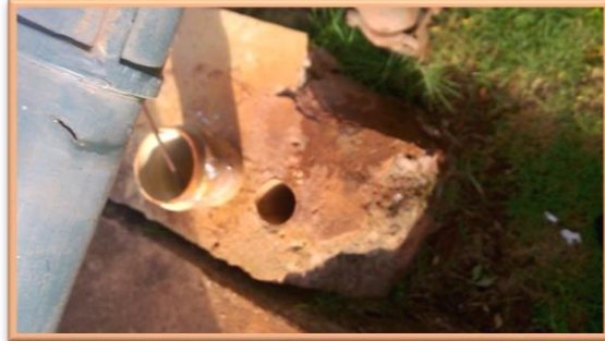
Vazamento na tubulação de entrada do REL-001
