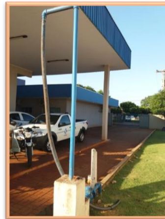
Abrigo coberto para veículos
