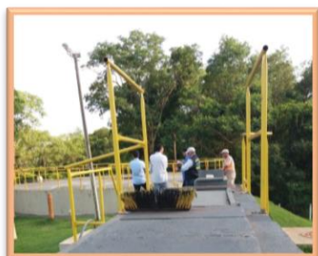
Vista do Reator UASB
