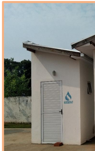
Unidade destinada a fluoretação desativada
