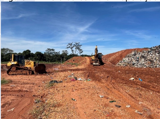
Figura 9 - Vista das máquinas na frente de trabalho.
