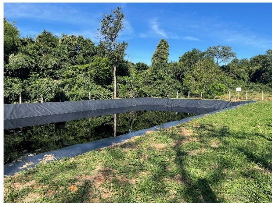
Figura 10 - Vista da lagoa auxiliar.
