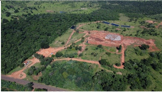
Figura 5 –Vista geral do Aterro Sanitário.
