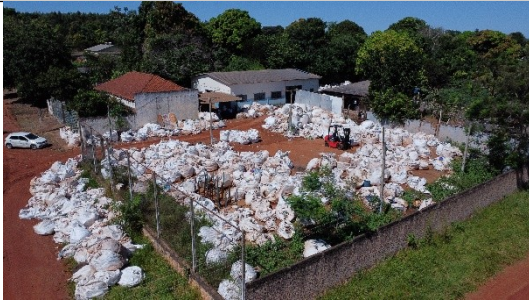
Figura 15 - Vista geral da UTR.
