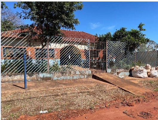
Figura 19 - Fachada da escola desativada que serve como UTR.
