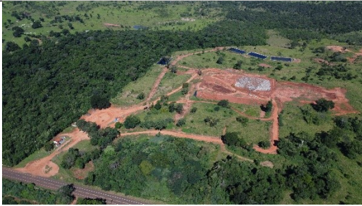
Figura 9 - Vista geral do Aterro Sanitário.
