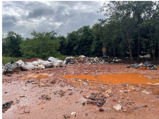
Figura 24 - Detalhe do pátio em más condições.
