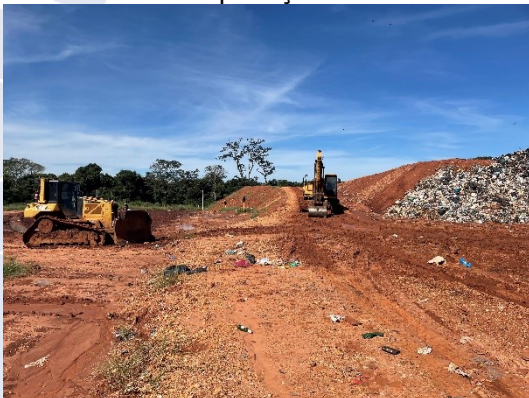
Figura 13 - Vista das máquinas na frente de trabalho.
