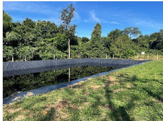
Figura 14 - Vista da lagoa auxiliar.
