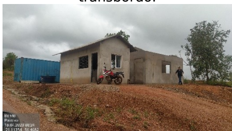
Figura 7 - Guarita em construção.
