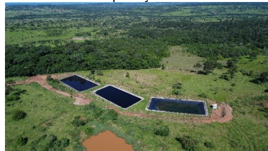
Figura 12 - Vista das lagoas de tratamento.
