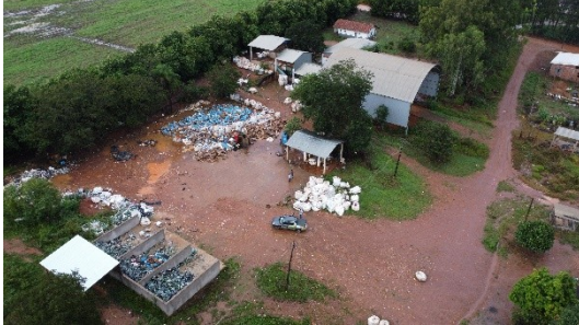
Figura 21 - Vista geral da UTR.
