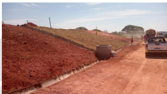
Figura 10 – Vista do Aterro Sanitário (Fonte: Proposta Engenharia Ambiental Ltda).
