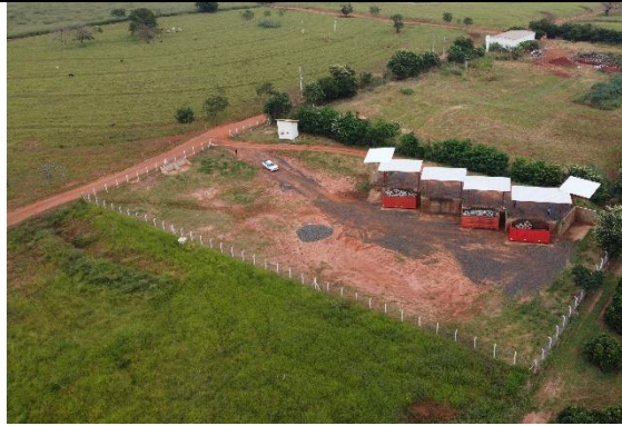
Figura 4 – Vista geral da área de transbordo.
