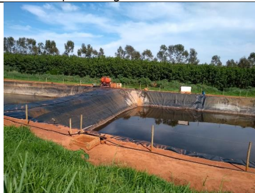
Figura 11 – Vista das lagoas de tratamento (Fonte: Proposta Engenharia Ambiental Ltda).
