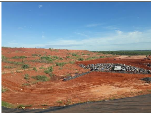
Figura 8 – Vista do Aterro Sanitário (Fonte: Proposta Engenharia Ambiental Ltda).
