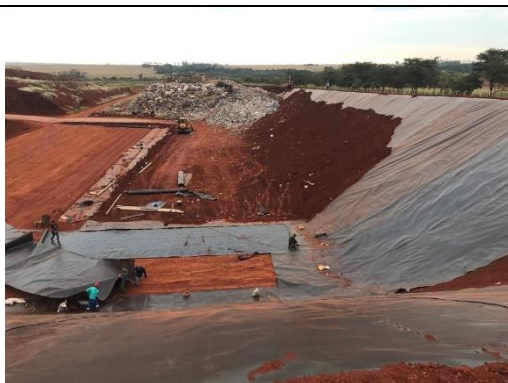
Figura 8 – Vista do Aterro Sanitário. Fonte: Financial Construtora Industrial Ltda.
