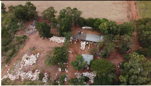
Figura 13 – Vista geral da UTR.
