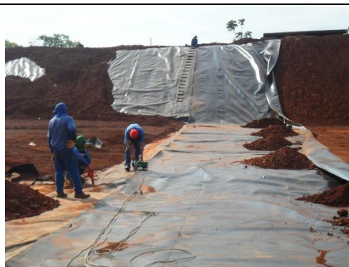
Figura 9 – Implantação do Aterro Sanitário. Fonte: Financial Construtora Industrial Ltda.
