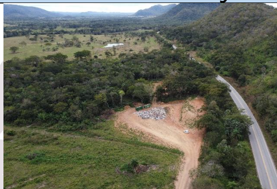
Figura 3 – Vista geral da área de transbordo, às margens da MS-339.
