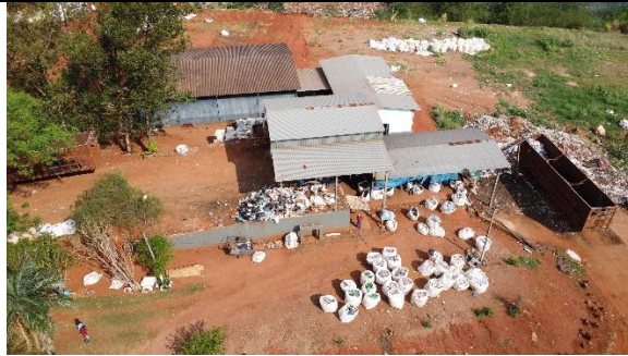
Figura 14 – Vista geral da UTR.
