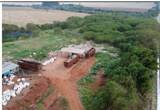
Figura 3 – Vista geral da área de transbordo, às margens da MS-156.
