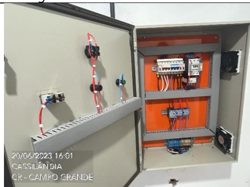
Figura 29 – Quadro de comando elétrico sem Diagrama Unifilar.
