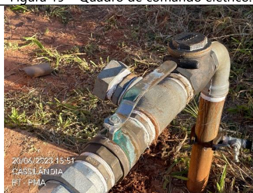
Figura 21 – Detalhe do cavalete sem macromedidor em operação.
