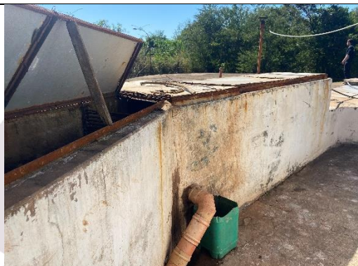
Figura 92 – Vista do gradeamento.
