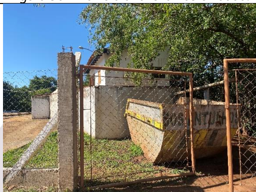
Figura 98 – Entrada da ETE.
