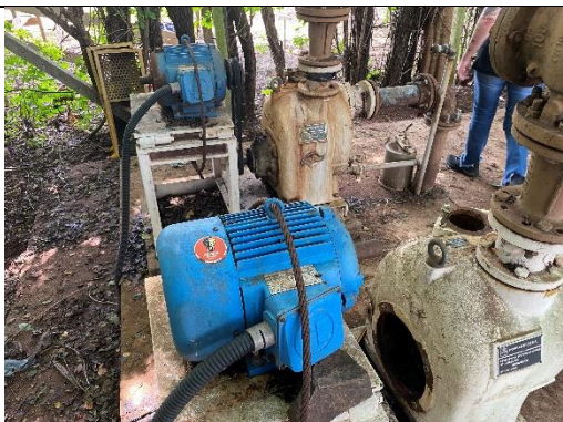
Figura 118 – Detalhe de moto bomba sem conjunto rotativo.
