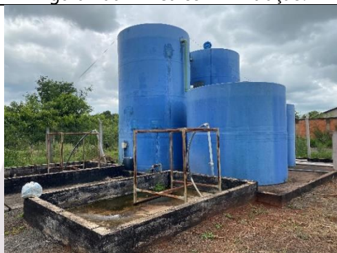
Figura 108 – Vista geral da ETE.
