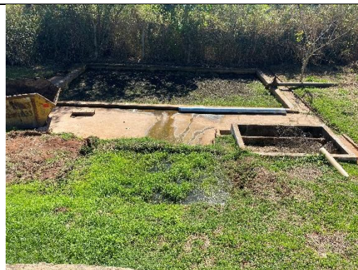
Figura 97 – Leito de secagem.
