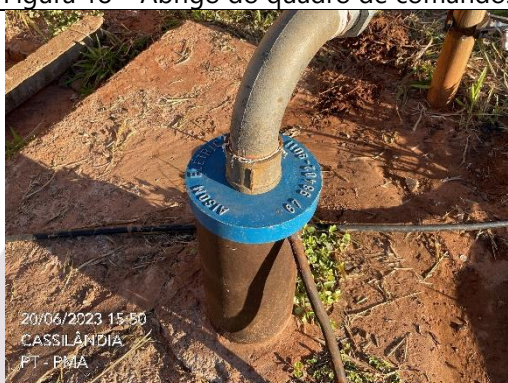
Figura 20 – Poço com laje de proteção.
