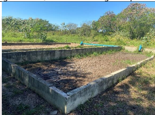
Figura 88 – Leito de secagem.
