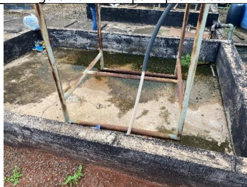
Figura 109 – Detalhe do Leito de Secagem.
