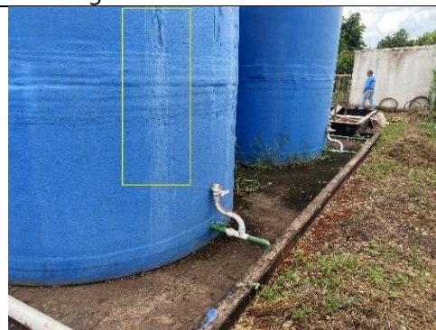
Figura 103 – Vazamento aparente.
