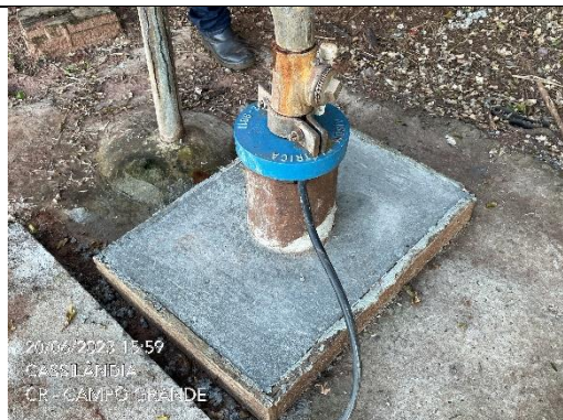
Figura 24 – Detalhe de laje de proteção.
