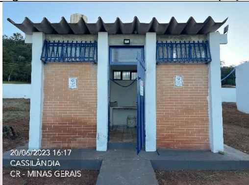
Figura 34 – Abrigo do quadro de comando e Unidade de Cloração de Água Tratada.
